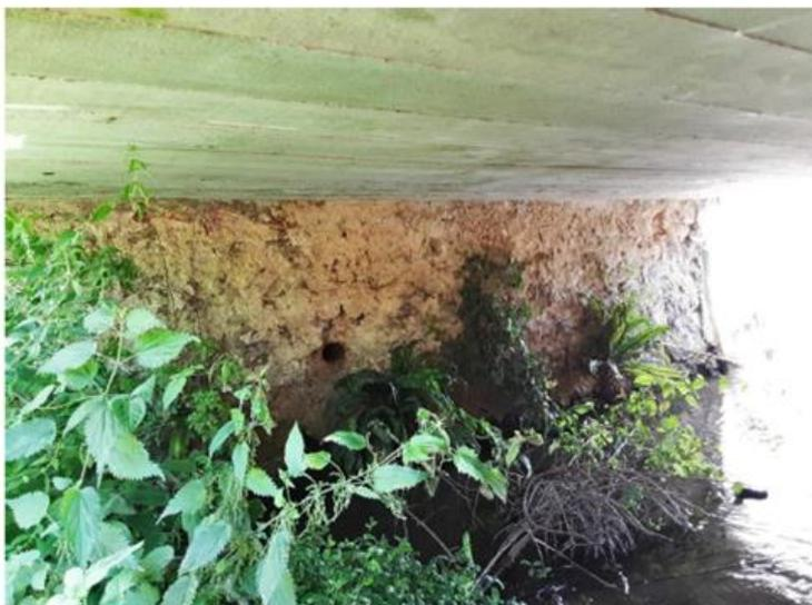
Les appuis sont en maçonnerie rejointoyée. Il n'y a rien à signaler sur l'état des appuis.
