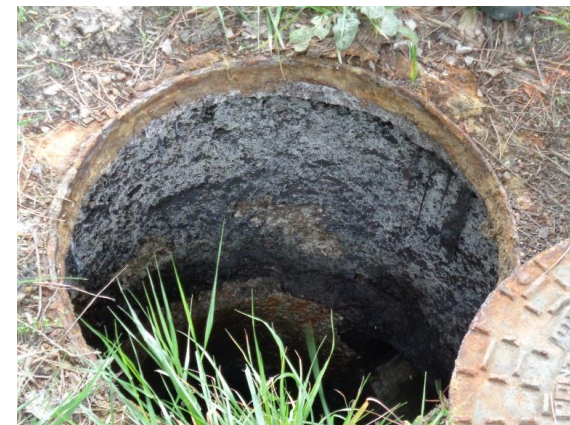
Réseau d'assainissement biodétérioré lié à la présence H_2S
