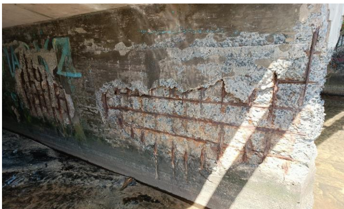
Pont de la rivière Vaitia – Manque d'enrobage / Corrosion
