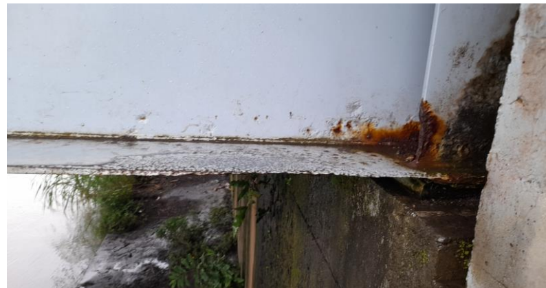
Pont de la rivière Parengo – Corrosion / diminution section
