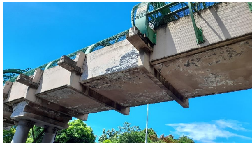
Passerelle Puurai – Corrosion béton armé / Absence d'étanchéité
